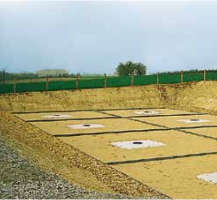
Filtres à sable.
