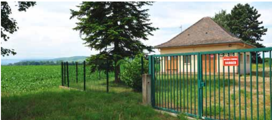
Captage d'eau potable
