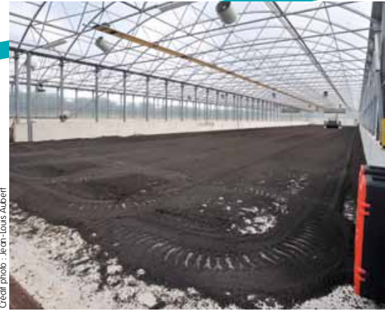
Séchage solaire des boues (Châteaulin, 29)
