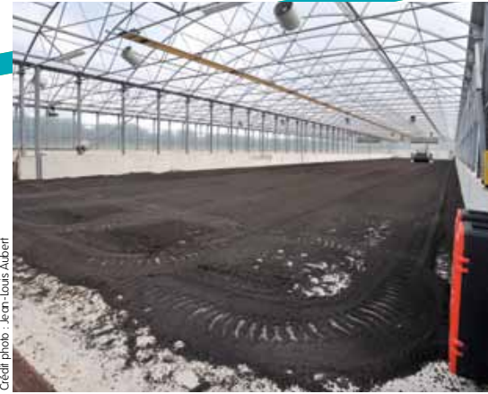
Séchage solaire des boues (Châteaulin, 29)
